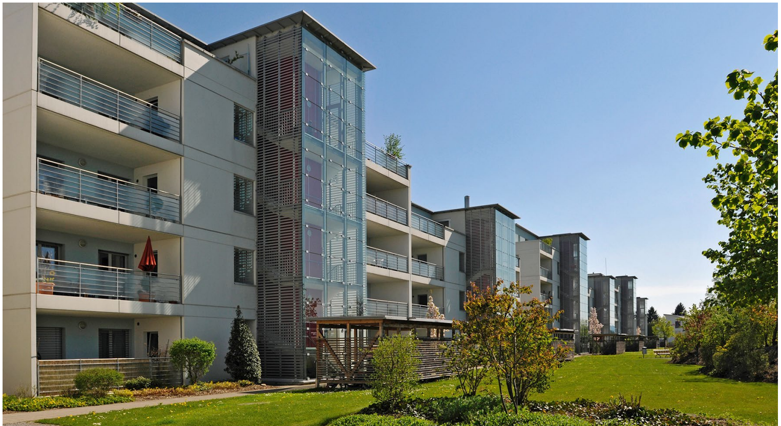
Überbauung Matten, Pfäffikon Transformation Matten, Pfäffikon Trasformazione Matten, Pfäffikon
