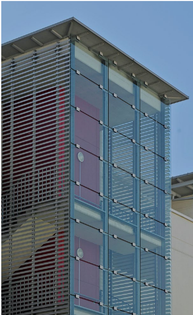
Überbauung Matten, Pfäffikon Transformation Matten, Pfäffikon Trasformazione Matten, Pfäffikon
