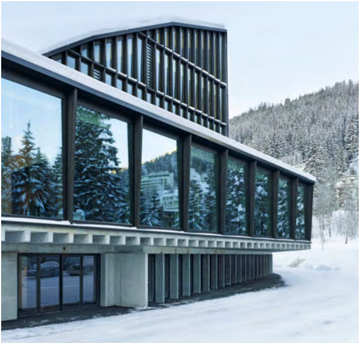
Vaillant Arena Davos © Architektur: Marques Architekten AG, Luzern; Fotograf: Ruedi Walti, Basel
