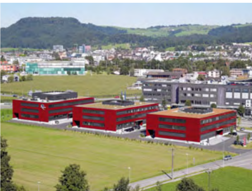
Büro- und Geschäftshaus IMPULS, Baar Architekt: Jego AG
