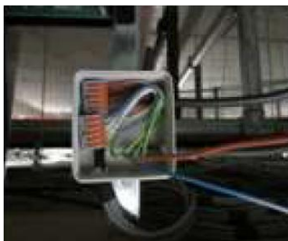
Elektrodose mit den Brücken WAGO
