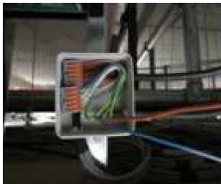
Prise électrique avec ponts WAGO
