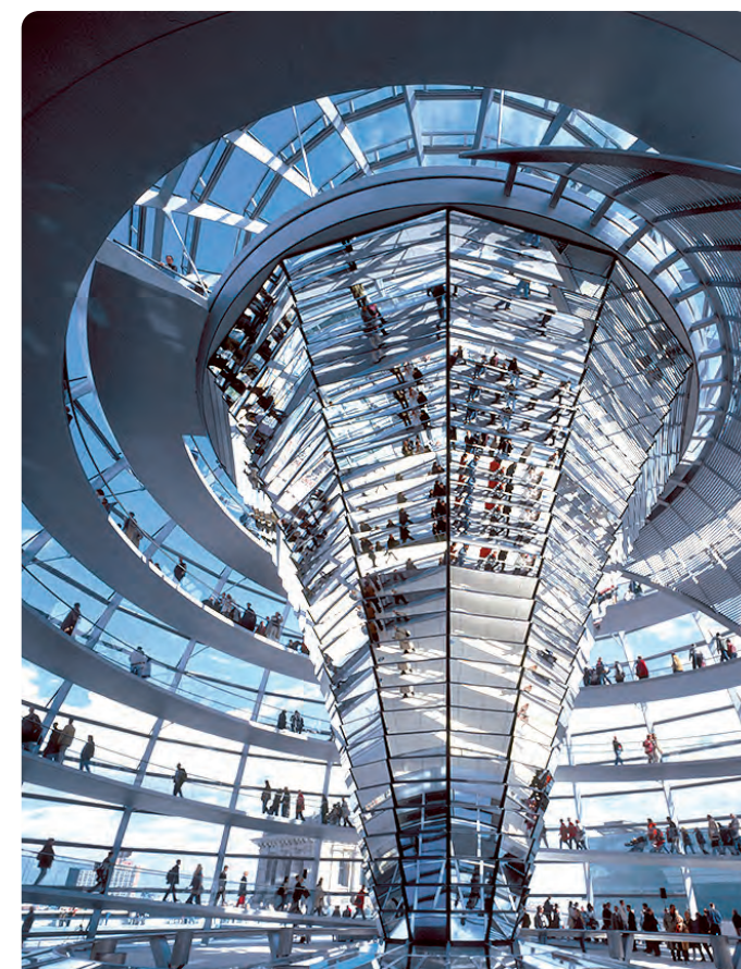
Reichstag, Berlin (D): E (EW) 30-Dachverglasung mit hohen Wärmedämm-, Schallschutz- und Sicherheitseigenschaften | Foto: HG Esch Photography / Pilkington | Pilkington Pyrodur®
