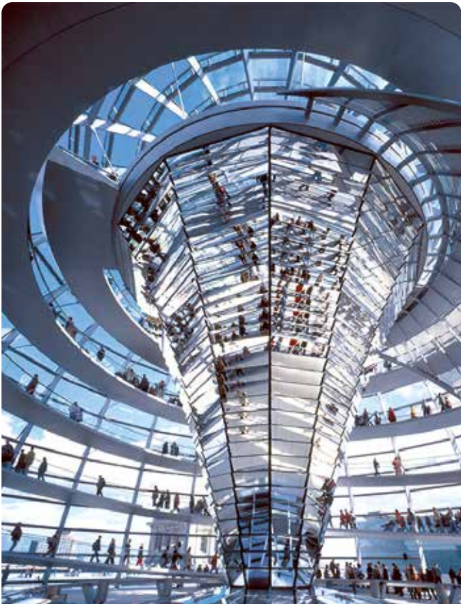
Reichstag, Berlin (D): Vitrage de toit E (EW) 30 ayant des caractéristiques d'isolation thermique, phonique et de sécurité renforcées | Photo: HG Esch Photography / Pilkington | Pilkington Pyrodur®
