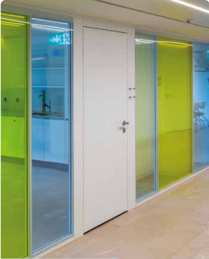
cloisons en verre de protection incendie combinées à un film teinté
