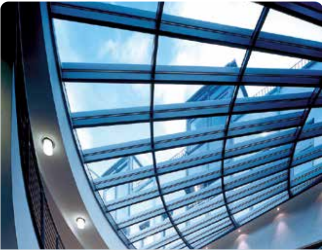
Sparkasse Starkenburg, Heppenheim (D): Structure des vitres d'un vitrage incliné E (EW) 30 | Photo: HG Esch Photography / Pilkington | Pilkington Pyrodur®
