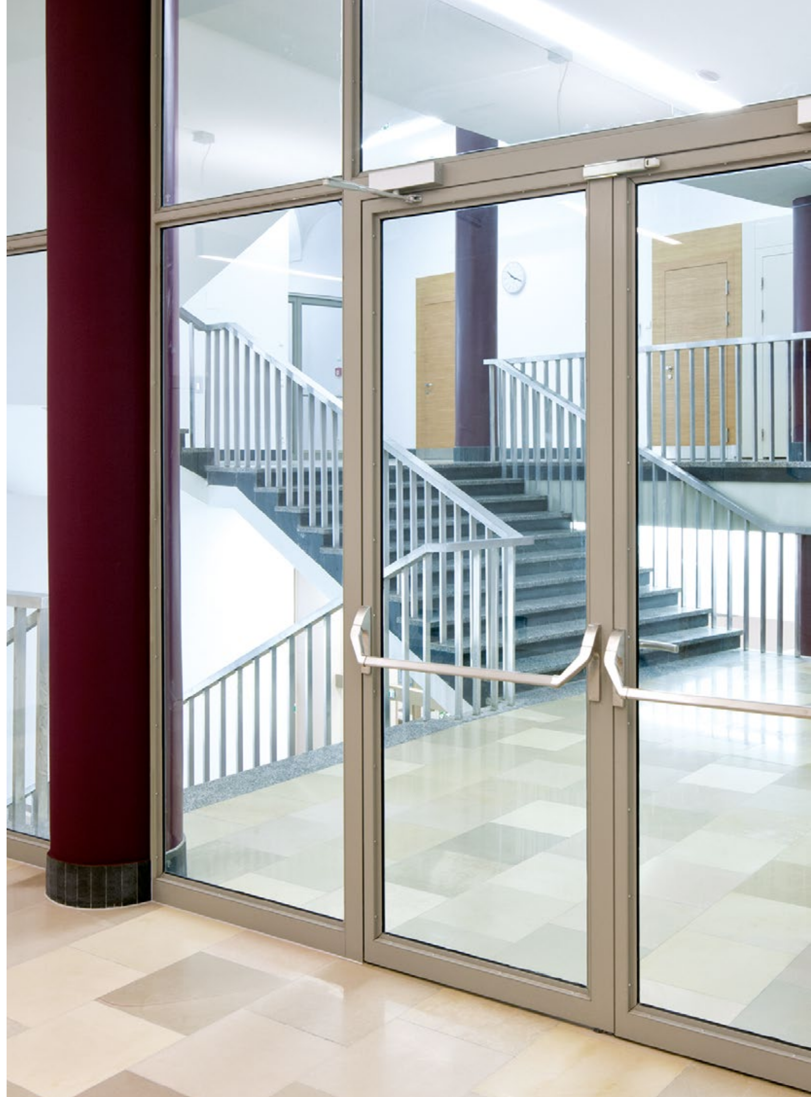
Universität für Musik und darstellende Kunst, Wien (AT): Separazione E 30 dalla tromba delle scale | Foto: HG Esch Photography / Pilkington | Pilkington Pyroclear®
