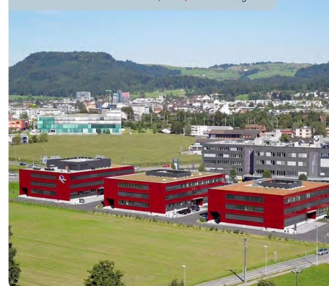
Büro- und Geschäftshaus IMPULS, Baar | Architekt: Jego AG
